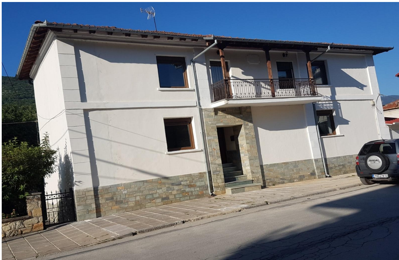
Εικ. 8. Το σπίτι του Β. Παπαγιάννη (σήμερα) όπου το 1930 είχε στεγαστεί προσωρινά το νεοϊδρυθέν Ε΄ Δημοτικό Σχολείο μέχρι την ολοκλήρωση της κατασκευής του νέου κτιρίου (φωτ Α. Γραμπόβας, 2024)
