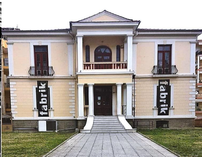
Εικ. 33 Το κτίριο του Γιάννη Ζήση όπου εγκαταστάθηκε και λειτούργησε για τελευταία φορά (1932-1934) μέχρι την κατάργησή
