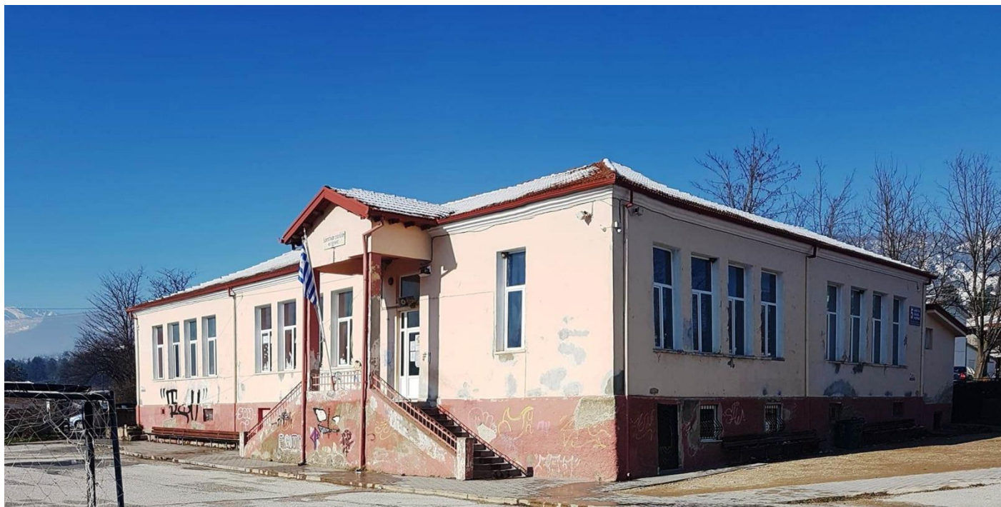
Εικ. 5 Το κτίριο του 5 ου Δημοτικού Σχολείου Φλώρινας (N/A πλευρά σε σχήμα Γ), σήμερα (φωτο Α. Γραμπόβας, 2024)
