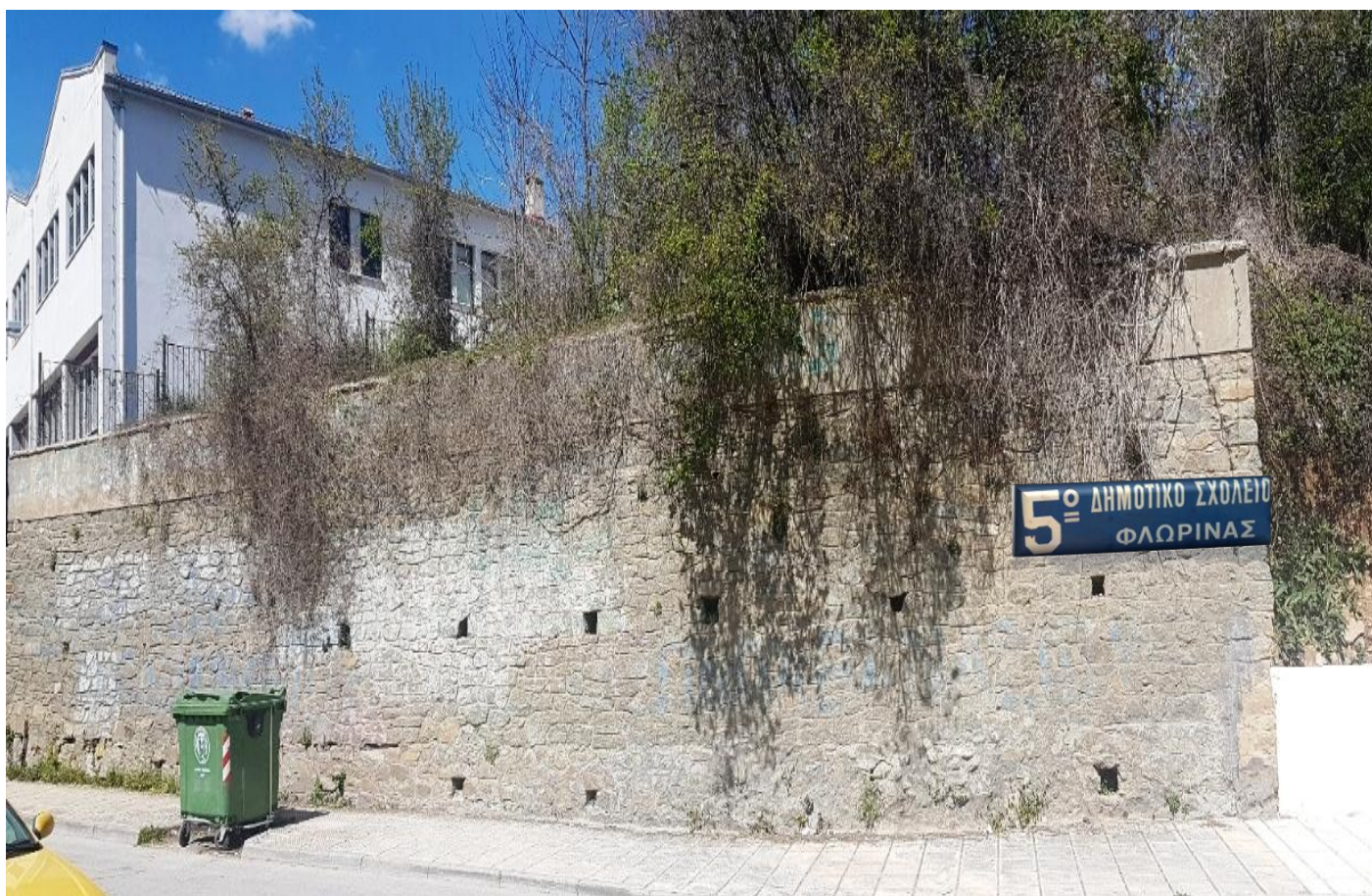
Εικ. 1.. Η παλιά λαμαρινένια πινακίδα με τον τίτλο του σχολείου που βρίσκονταν στο νότιο τμήμα του οικοπέδου του σχολείου, στο τοίχιο αντιστήριξης, πριν από την ανέγερση του κτιρίου για τη στέγαση των Ειδικών Πειραματικών Σχολείων (αριστερά) (φωτο Α. Γραμπόβας))
